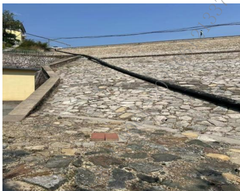
走马庄副坝坝坡现状
