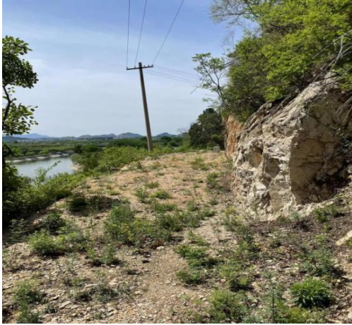
通往启闭机室道路现状
