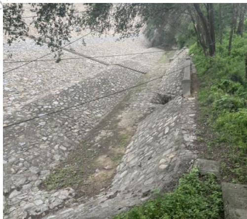
走马庄III号副坝排水沟
