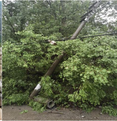
冲断架空线杆
