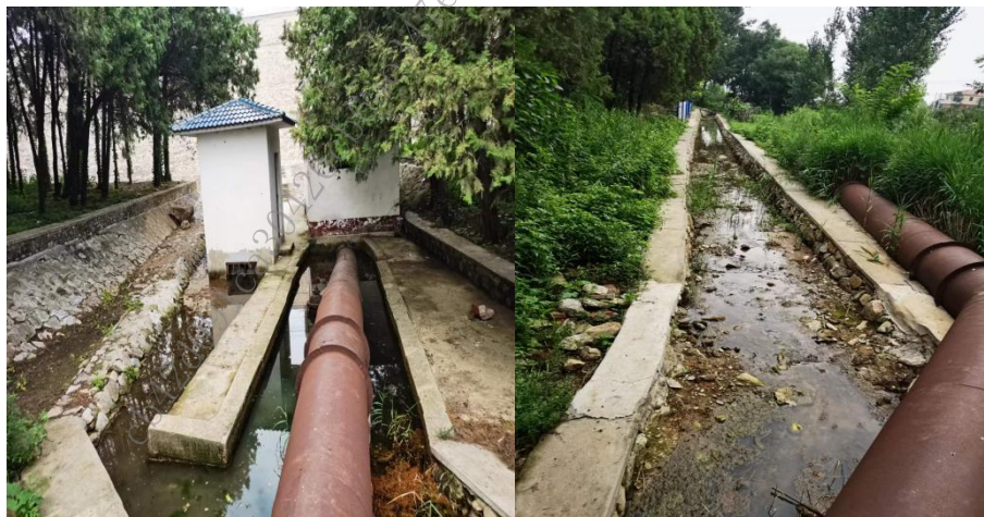
南石骆驼副坝量水堰下游现状
