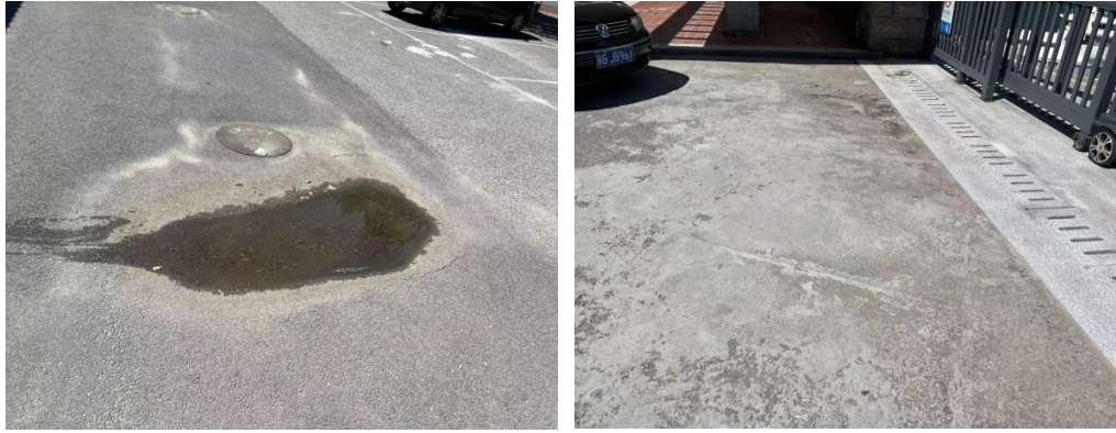
白河码头地面现状
