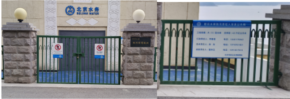
大门及栏杆现状
