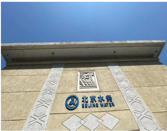
闸室外墙现状
